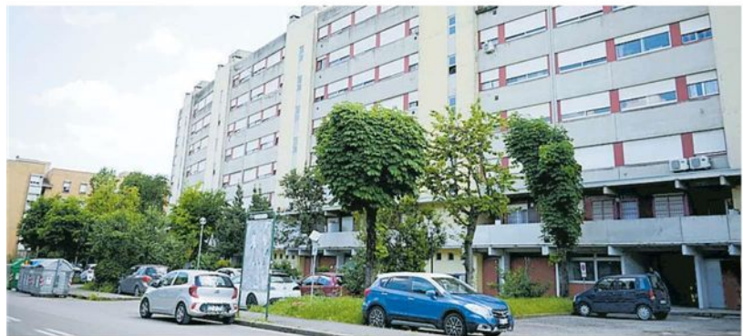
▲ Edilizia popolare | caseggiati del quartiere Pilastro
