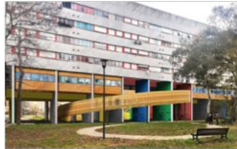
Intervento Trancia H - ante e post-operam.
